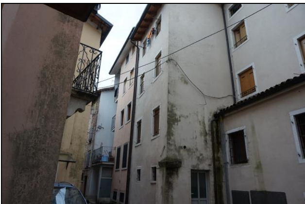
Fabbricato da Via del Maglio ad est
