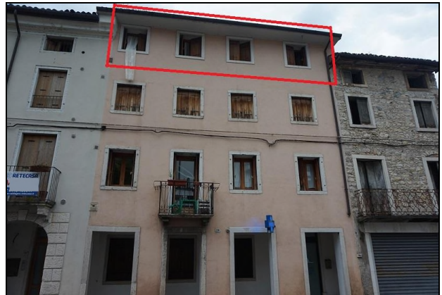
Fronte ovest fabbricato da Via C. Battisti
