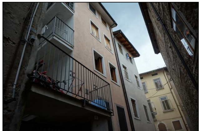
Fabbricato da Via del Maglio ad est
