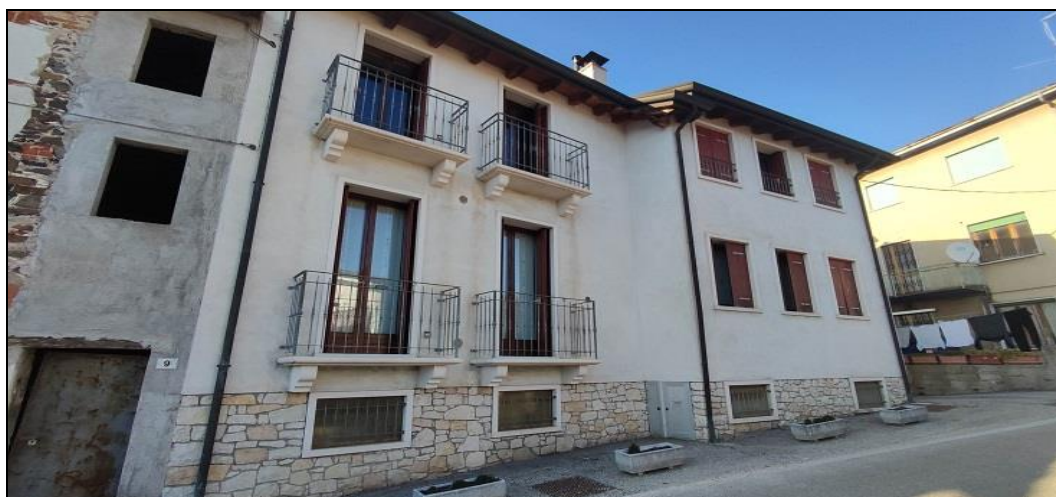
Vista esterna dell'abitazione - lato sud-est via Zenari
