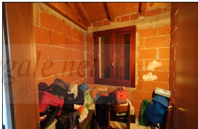
Piano primo – bagno al grezzo
