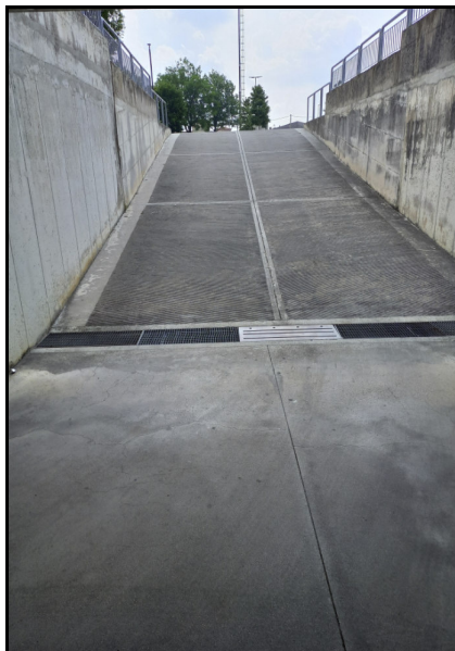
RAMPA DI ACCESSO GARAGE
