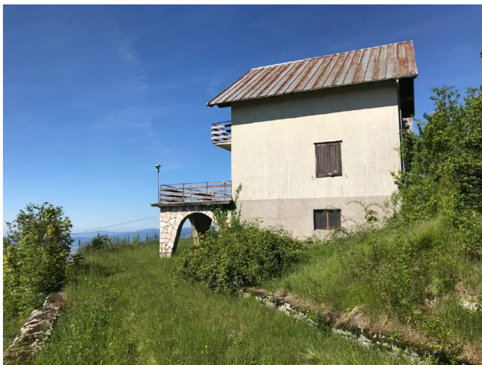
Veduta del lato est.
