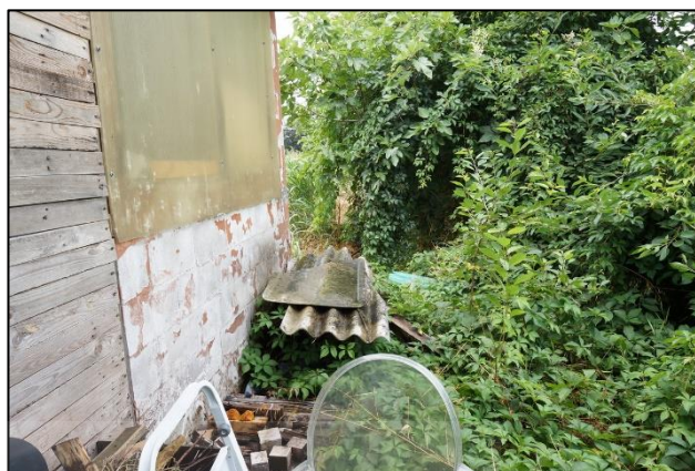
foto 24 - parete est a confine con la roggia (coperta)
