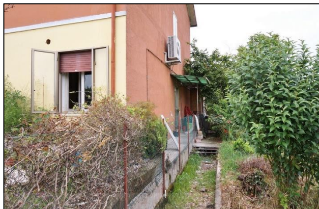
foto 4 - Roggia a confine con il lotto
