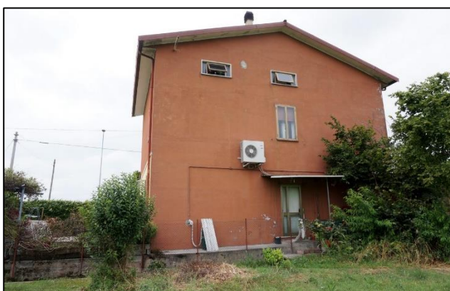
foto 3 - Prospetto posteriore verso la roggia
