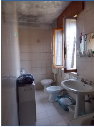
Bagno piano primo
