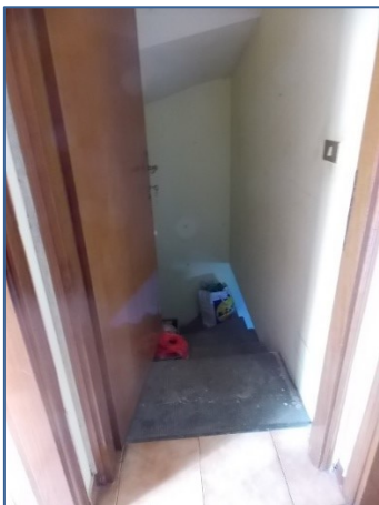
scala accesso piano seminterrato
