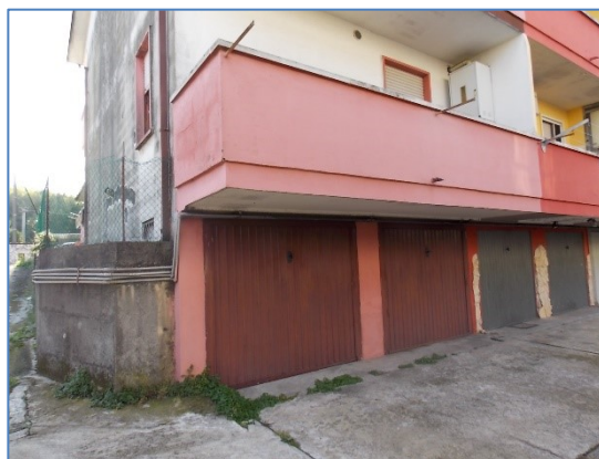
Spigolo N/E, ingressi autorimesse in proprietà
