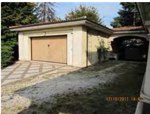
Vista esterna - Garage
