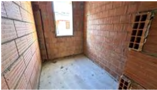
Vista interna - Stato dei lavori
