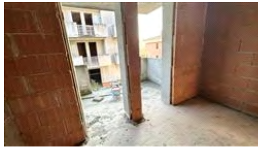
Vista interna - Stato dei lavori
