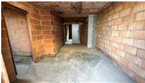
Vista interna - Stato dei lavori
