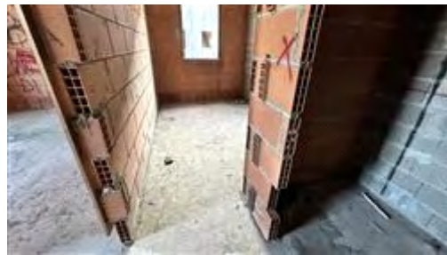
Vista interna - Stato dei lavori
