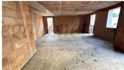
Vista interna - Stato dei lavori
