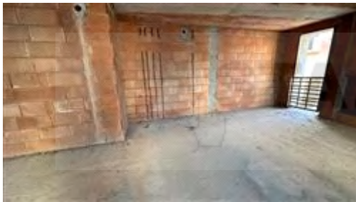
Vista interna - Stato dei lavori
