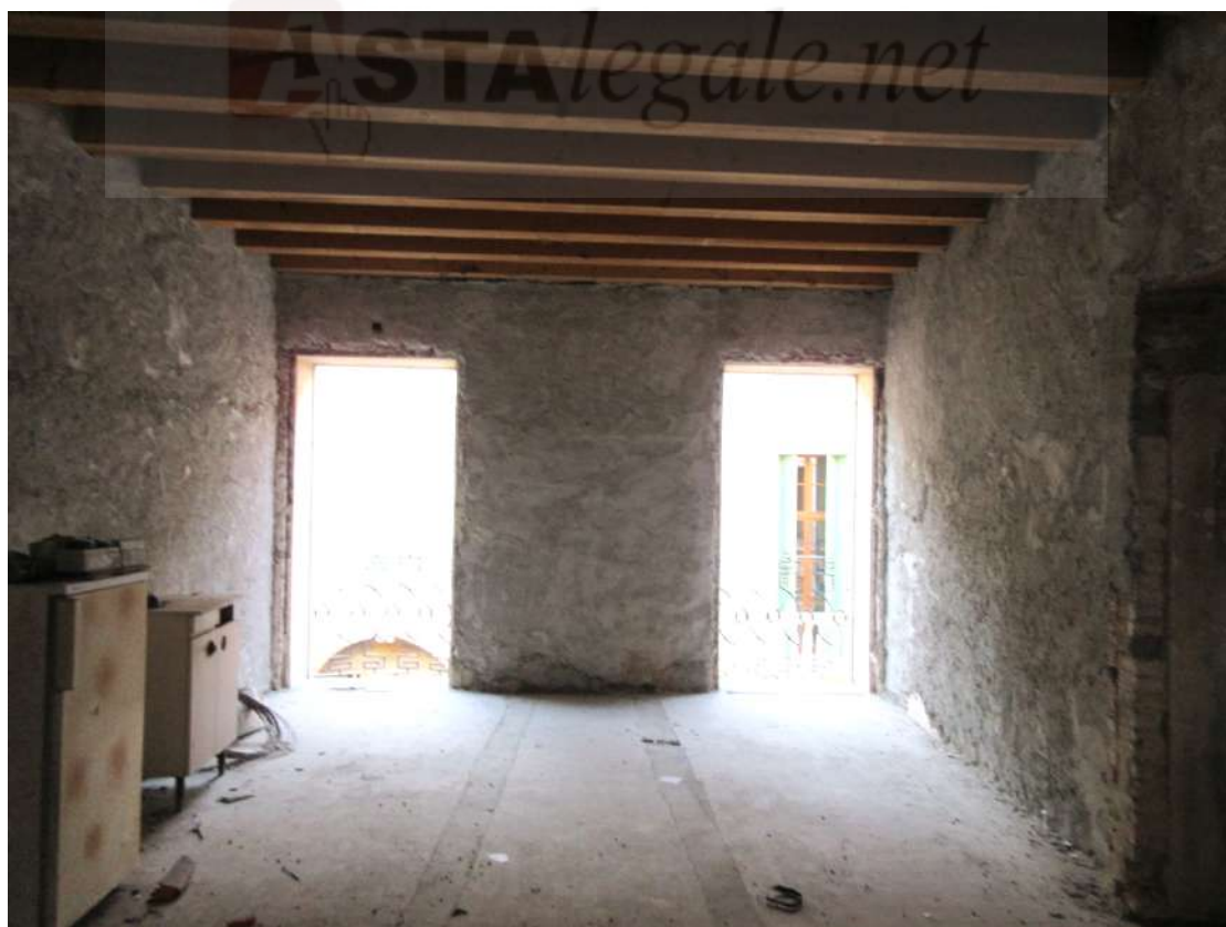
interno locale 2 verso corso Palladio
