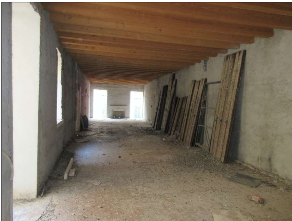
vista locale 1 verso corso Palladio
