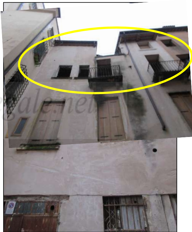
retro dell'edificio su stradella San Giacomo
