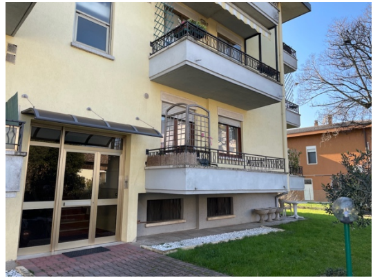
Foto 3. Esterno – Est – Accesso comune al fabbricato
