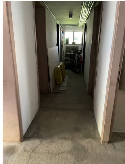
Foto 27. Corridoio comune di accesso al piano seminterrato
