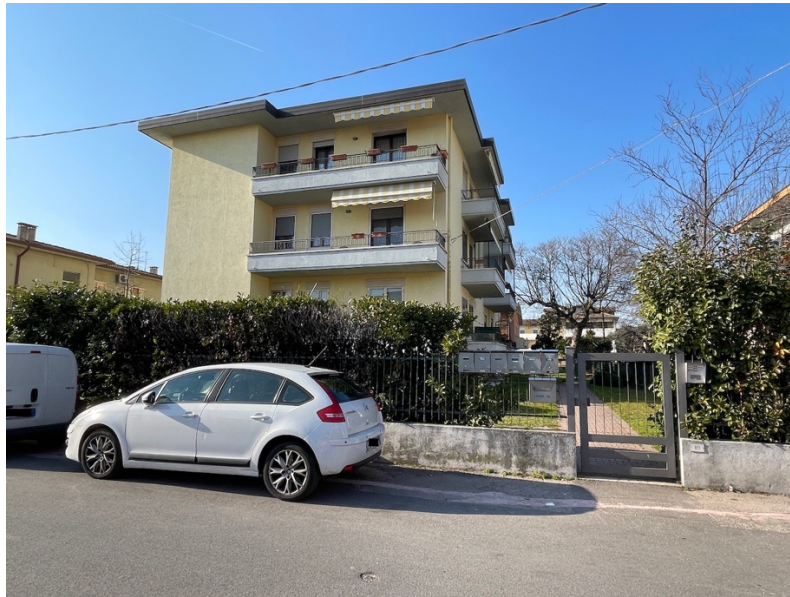
Foto 1. Inquadramento generale - Sud- vista da Via Verona
