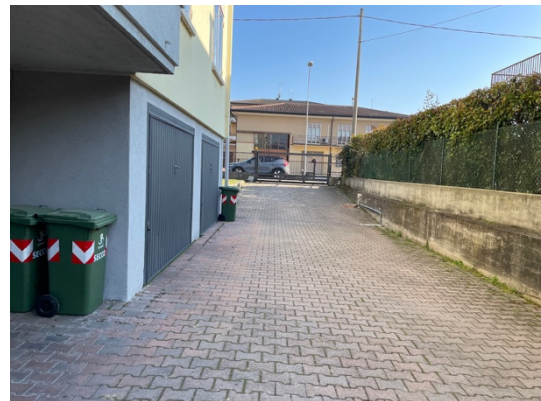
Foto 29. Accesso al piano seminterrato lato autorimesse - Ovest
