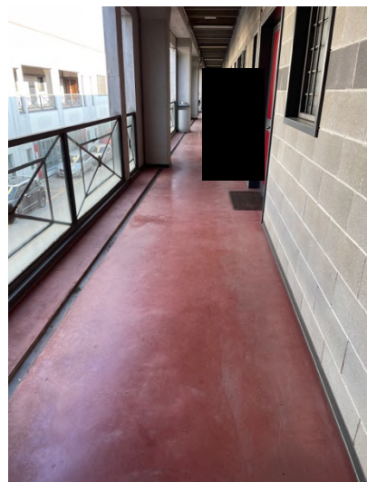
Foto 7. Ballatoio comune al piano primo
