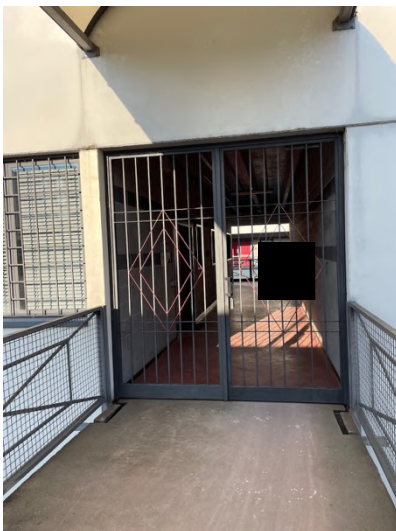
Foto 6. Ballatoio comune al piano primo
