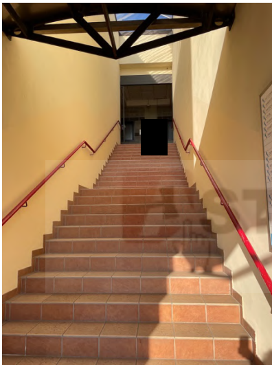
Foto 4. Vano scala comune
