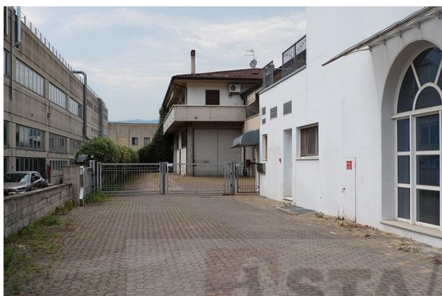
Corsia pedonale e carraia a sud della Particella 925
