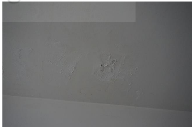
Piano primo – Particolare soffitto camera a sud/ovest
