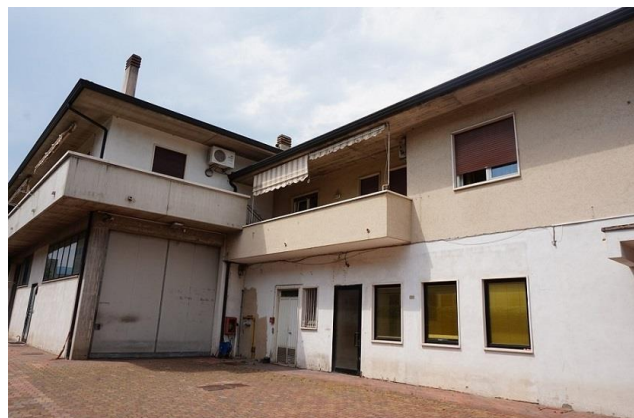
Fronte sud fabbricato da corte comune
