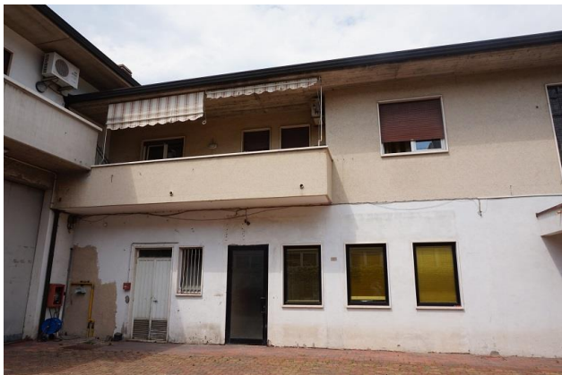
Particolare fronte sud con poggiolo e ingresso C.T.
