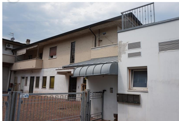
Fronte sud fabbricato da ingressi pedonale e carraio
