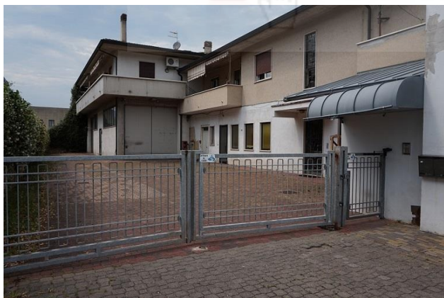
Particolare cancelli carraio e pedonale e fronte sud
