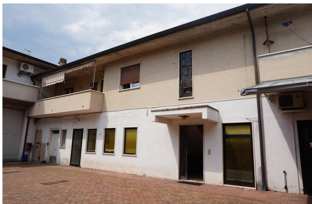
Fronte sud fabbricato da corte comune
