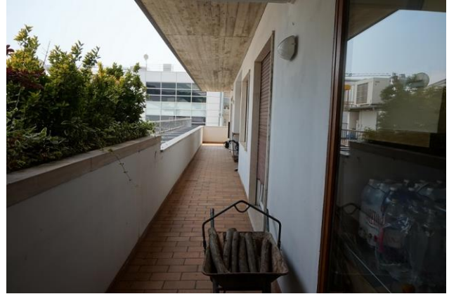
Piano primo – Poggiolo a est da nord verso sud
