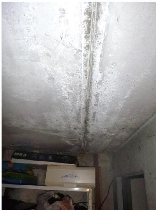
Abitazione mapp. 1019 sub. 4 – Infiltrazioni nel solaio del piano Interrato
