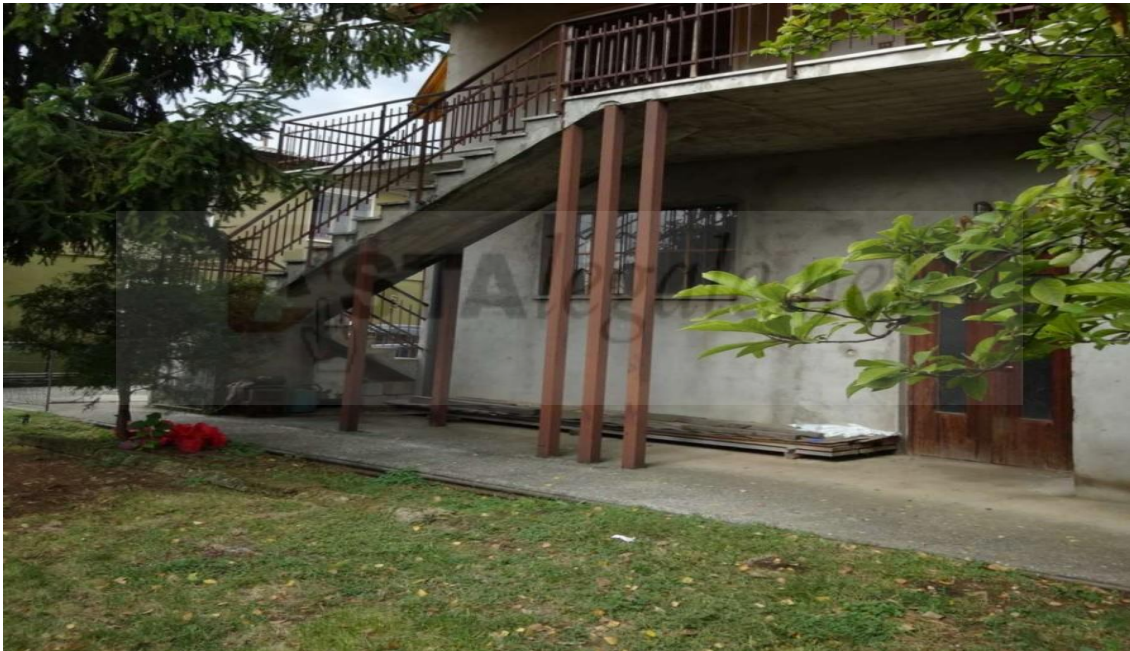
Figure 17- Ingresso-ballatoio e zona sottoscala-portico
