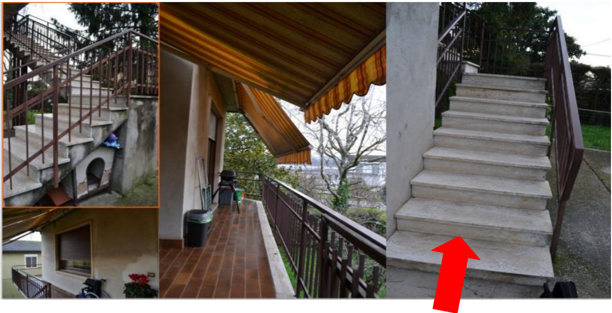
Fig.13-14-15-16- Ingresso- vano scale esterno
