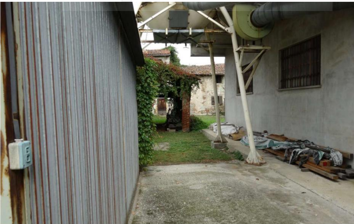
Figure 11 – 12- IMMOBILE PREFABBRICATO IN LAMIERA DA DEMOLIRE
