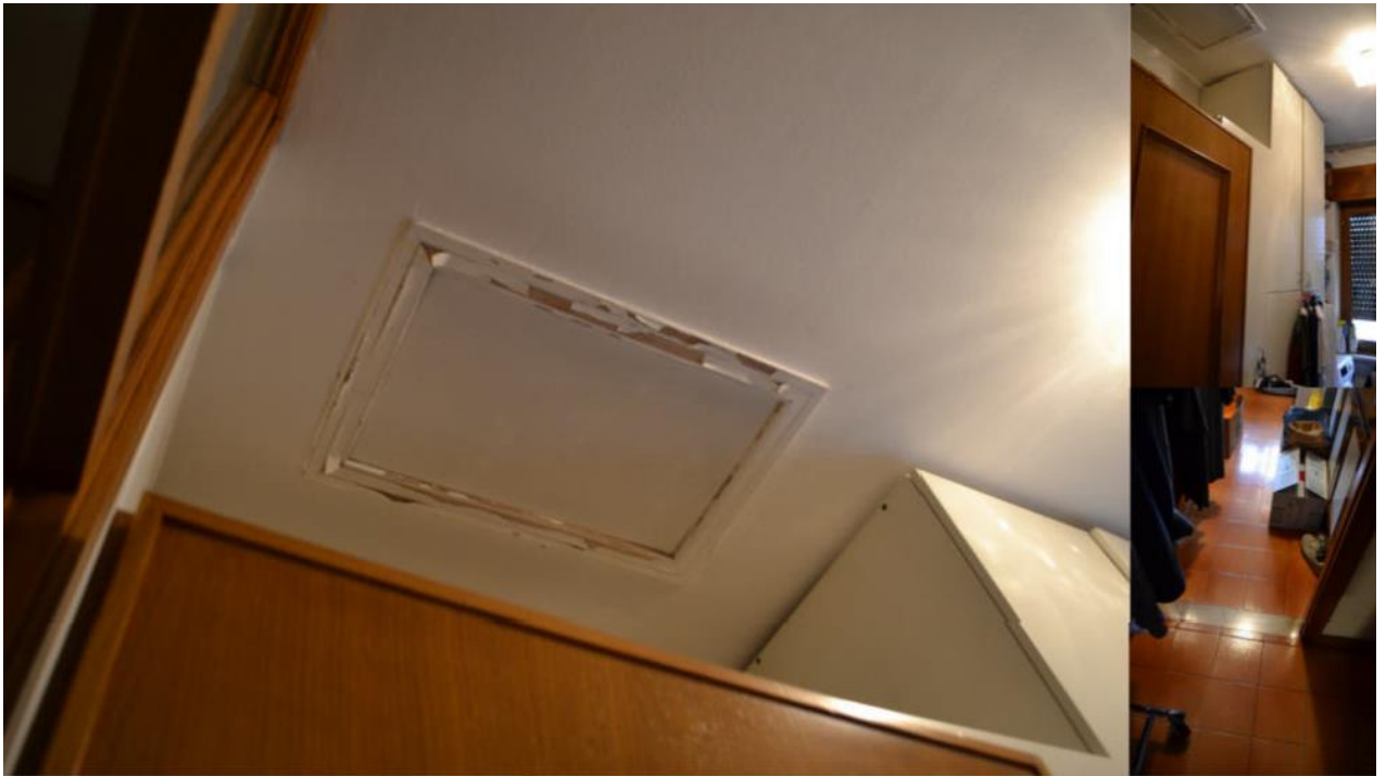
Figure 60-61-VANO LAVANDERIA DOTATO DI BOTOLA DI ISPEZIONE SUL SOTTOTETTO
