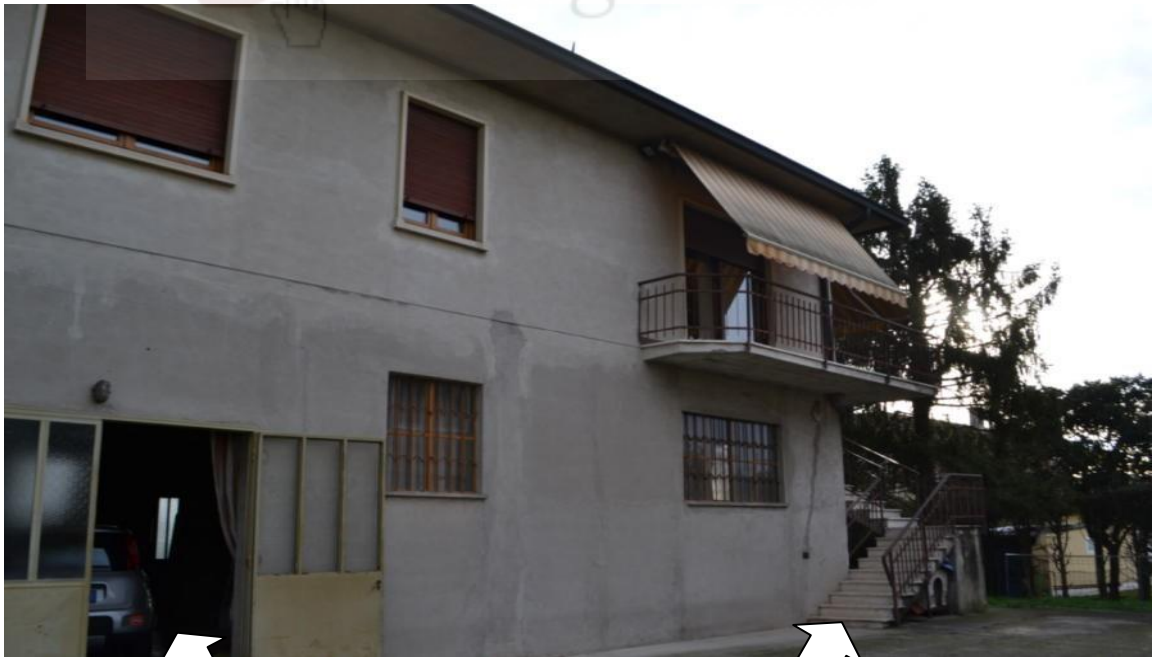
Fig.19- Ingresso al fabbricato artigianale
