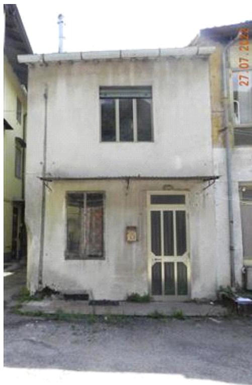
Facciata sul retro
