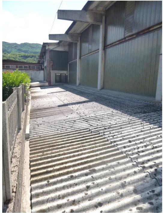
Capannone mappale 335 sub. 5 – copertura delle tettoie a Nord/Est in Eternit (amianto)
