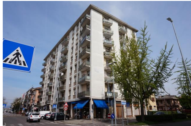
Vista fronti sud e st fabbricato da Viale della Stazione
