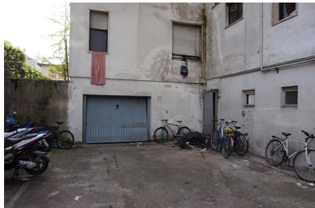
Piano interrato – Portone comune accesso autorimesse
