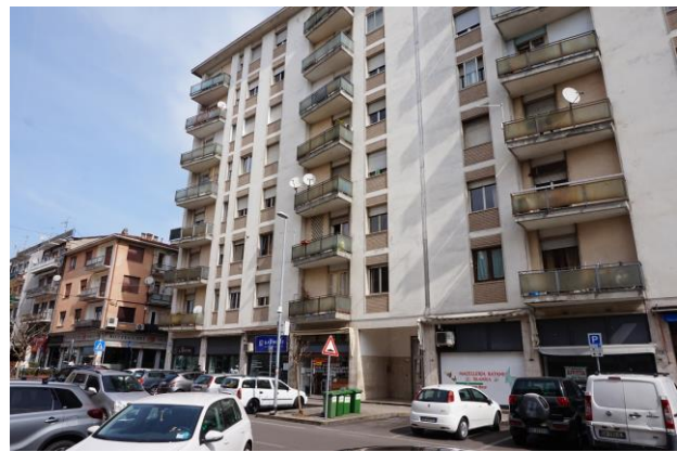
Vista fronte sud fabbricato da Viale della Stazione
