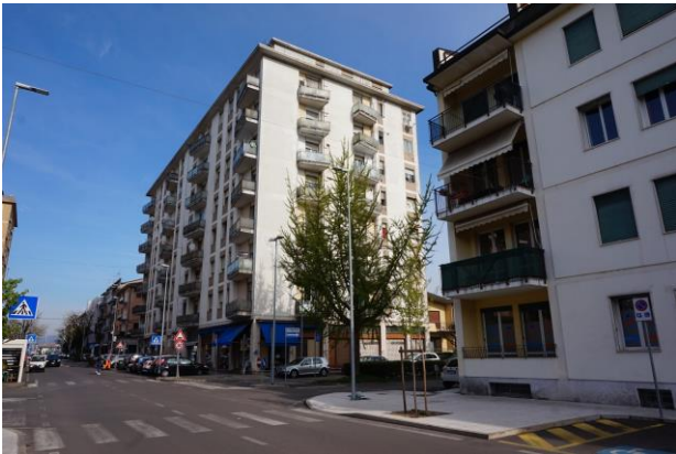
Vista fronte est fabbricato da Viale della Stazione
