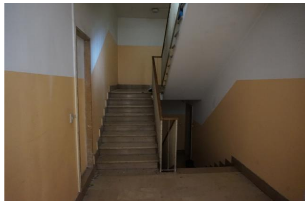
Piano Terra – Particolare rampa scale comune
