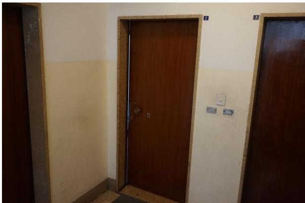
Piano Primo – Ingresso appartamento da pianerottolo
