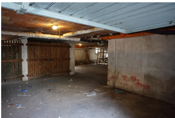
Piano interrato – Corsia comune coperta autorimesse
