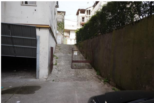
Piano interrato – Rampa scivolo da est verso ovest
