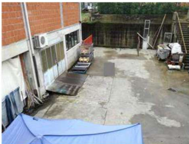
Area di manovra esterna sub. 32.
