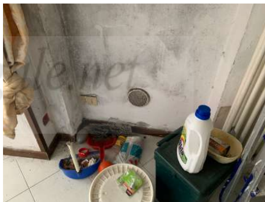
Dettaglio muro interno.
