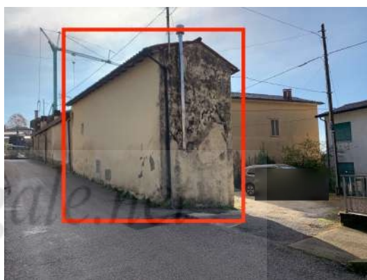
Vista dalla strada (lati est e nord)
