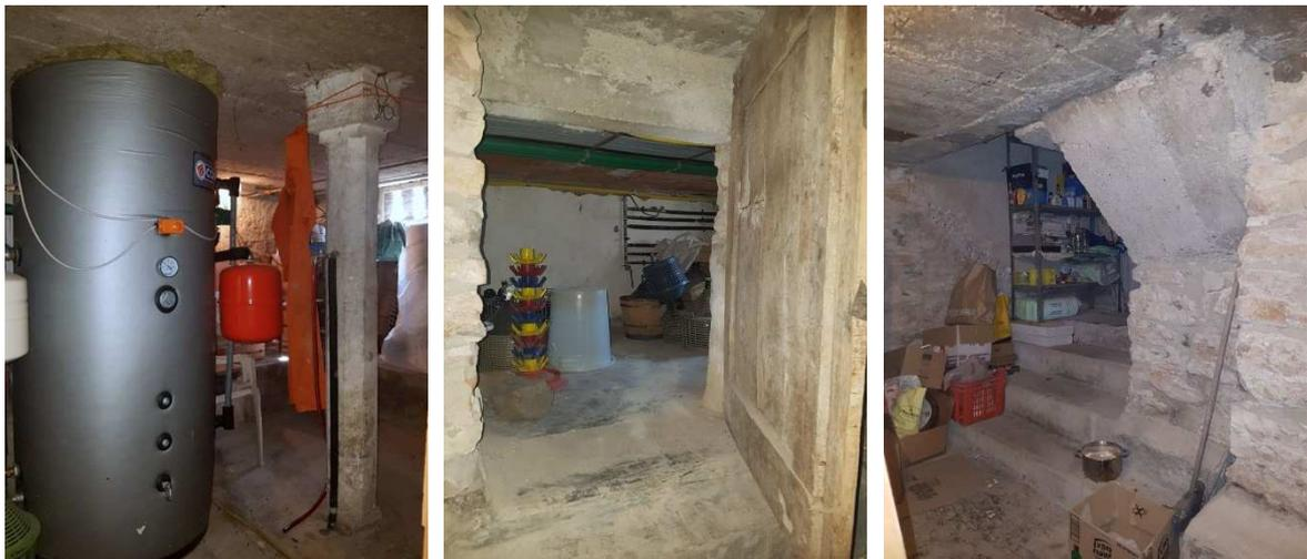
Impianto termico con brucatori (n.1 piano terra, n.1 piano primo) a biomassa con boiler (piano cantine) con corpi radianti ad elementi tubolari in acciaio (Libretto d'impianto con accensione 2007).
