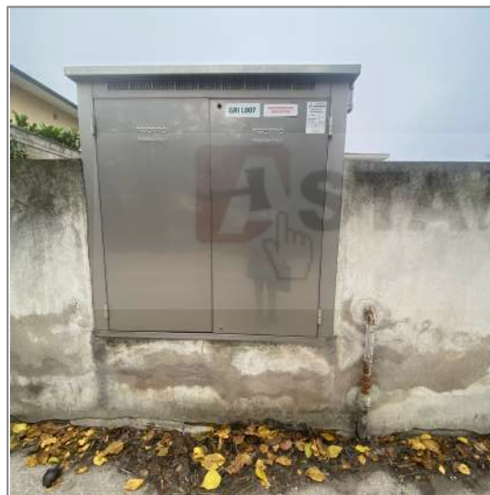
Predisposizione per allacciamento gas metano ed energia elettrica
