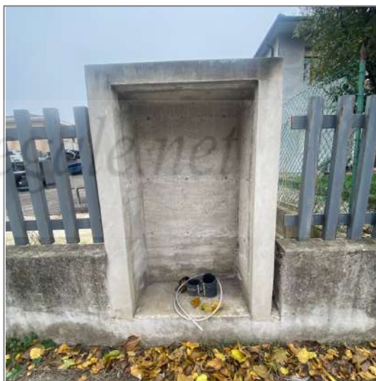
Predisposizione per allacciamento gas metano ed energia elettrica
