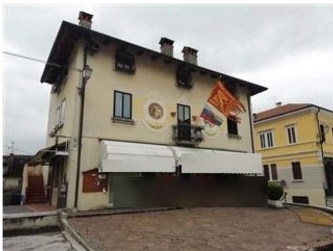
Vista esterna da Nord-Est
