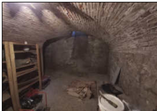
CANTINA PIANO INTERRATO
