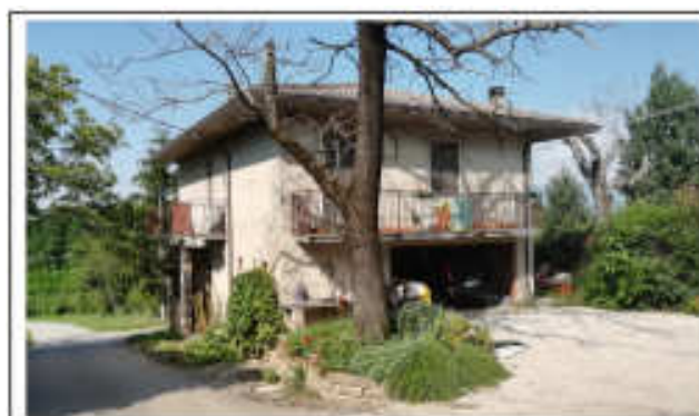
Vista da nord-est
