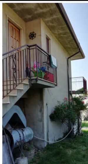
Scala di accesso al piano primo lato ovest
