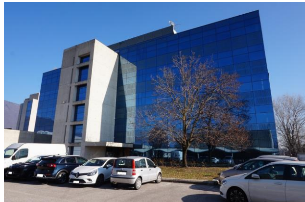
Vista fronte ovest fabbricato da area di corte
