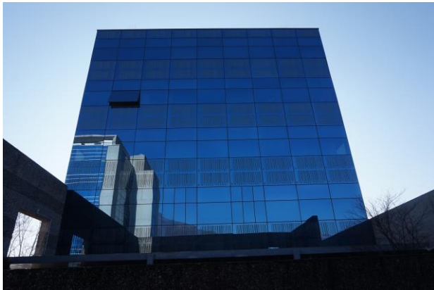
Vista fronte nord fabbricato da area di corte
