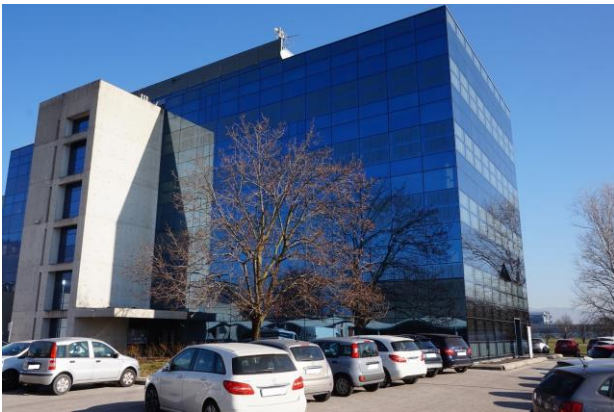
Vista fronti sud e ovest fabbricato da area di corte
