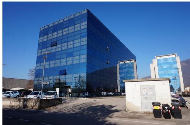
Vista fronte sud fabbricato da via Lago di Lugano
