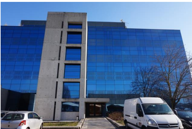
Particolare fronte ovest fabbricato da area di corte
