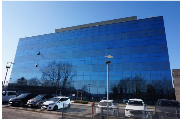
Vista fronte est fabbricato da area di corte
