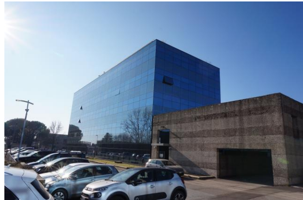
Vista fronti nord e est fabbricato da area di corte
