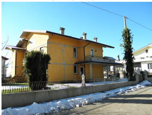
VISTA NORD EST
