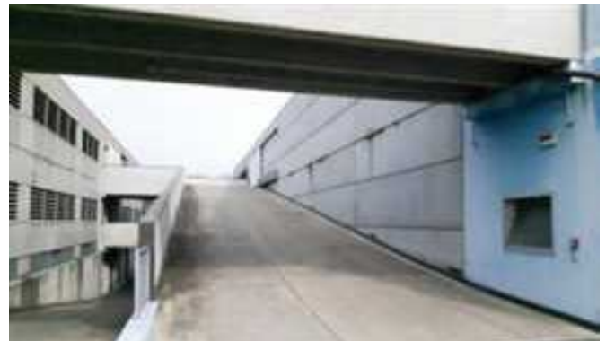
Vista della rampa di collegamento con il piano primo
