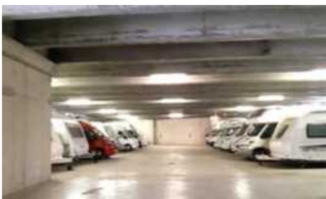
Vista della corsia di manovra del piano interrato
