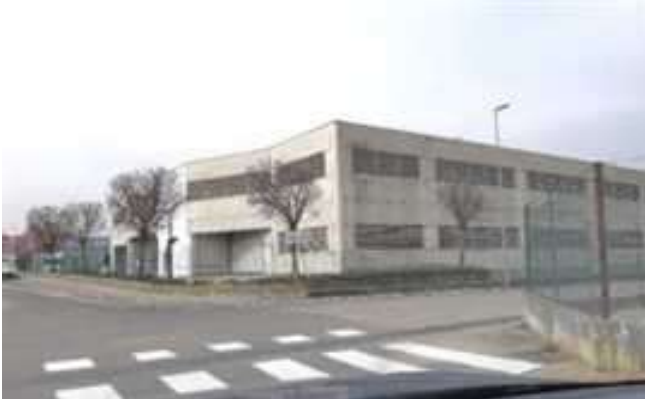
Vista del fabbricato uso rimessa per camper
