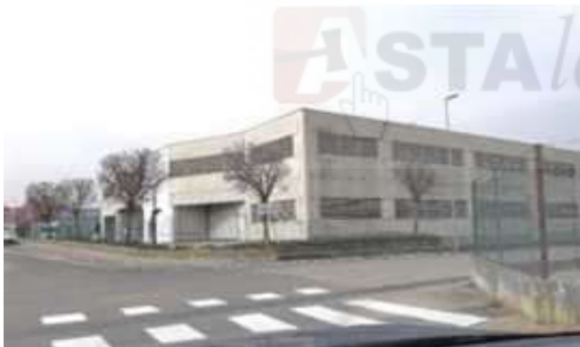
Vista del fabbricato uso rimessa per camper
