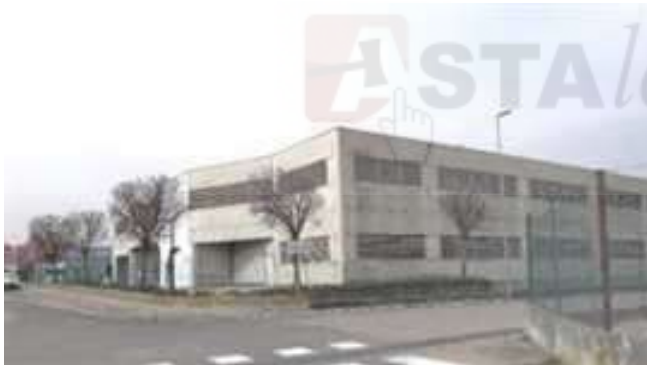
Vista del fabbricato uso rimessa per camper
