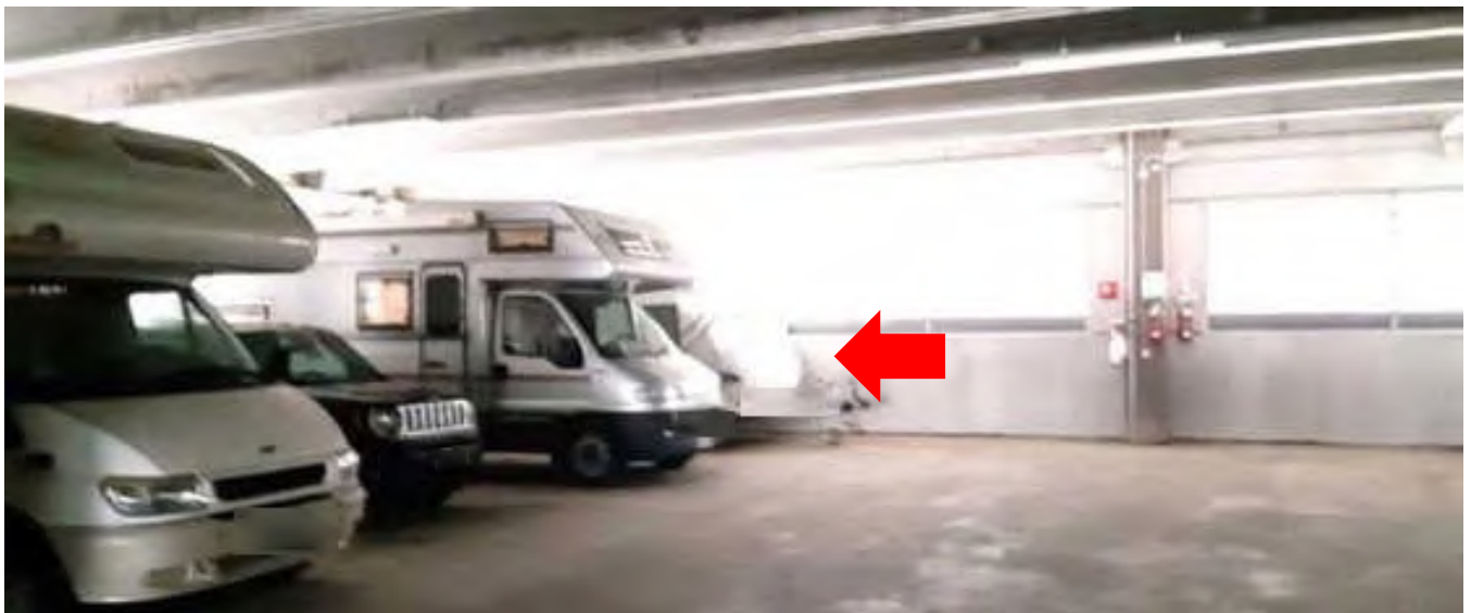
Vista della corsia di manovra con il sub 43
