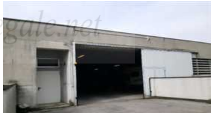
Vista del portone di ingresso al piano primo
