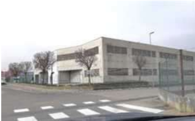
Vista del fabbricato uso rimessa per camper
