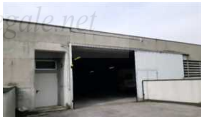
Vista del portone di ingresso al piano primo
