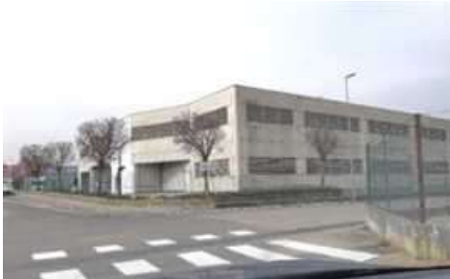
Vista del fabbricato uso rimessa per camper
