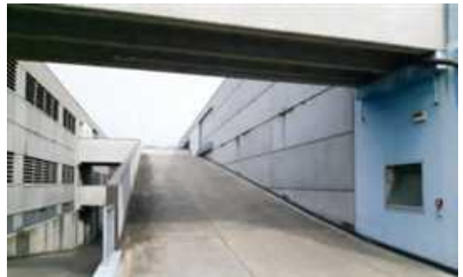
Vista della rampa carrabile di collegamento al P1°
