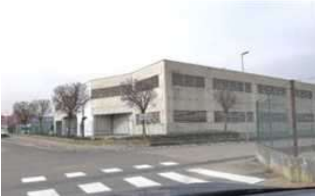
Vista del fabbricato uso rimessa per camper
