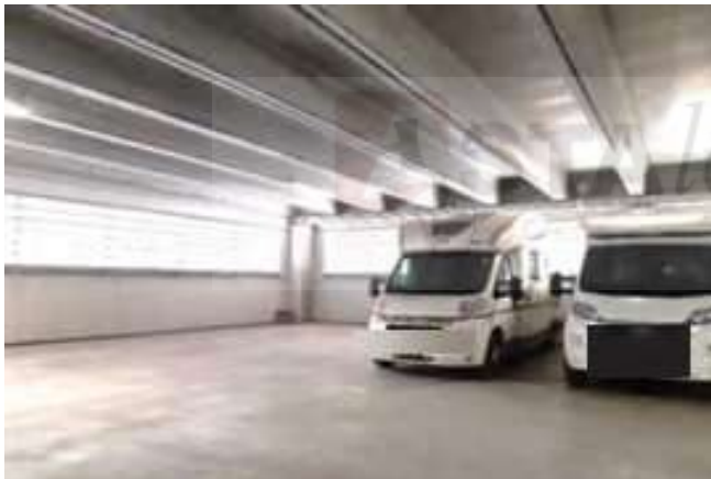
Vista interna dellacorsia della rimessa sub 138
