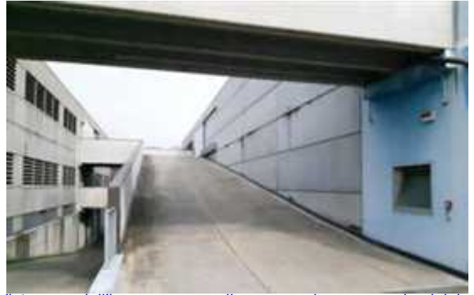
Vista dell'ingresso alla scala condominiale
