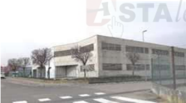
Vista del fabbricato uso rimessa per camper
