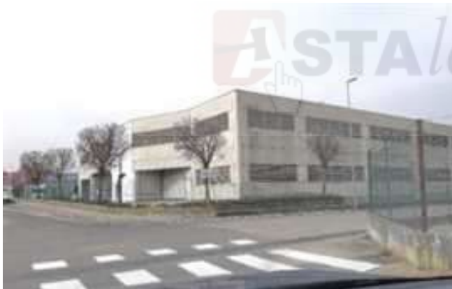
Vista del fabbricato uso rimessa per camper
