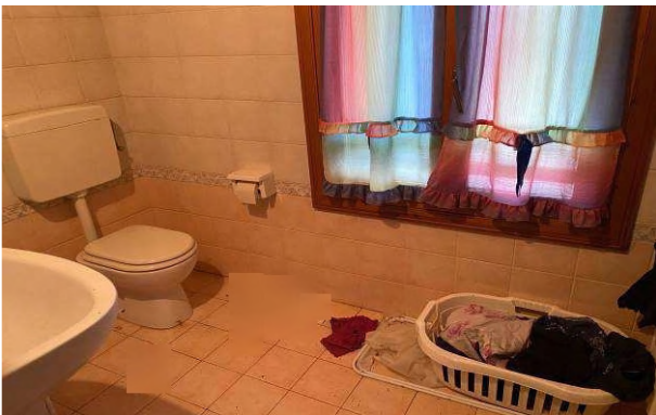
Bagno piano secondo
