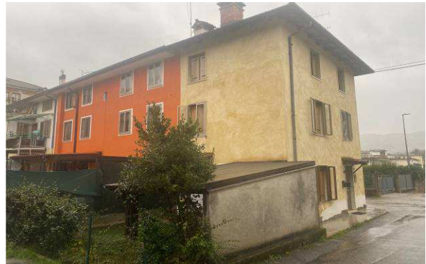
Vista esterna da sud-ovest
