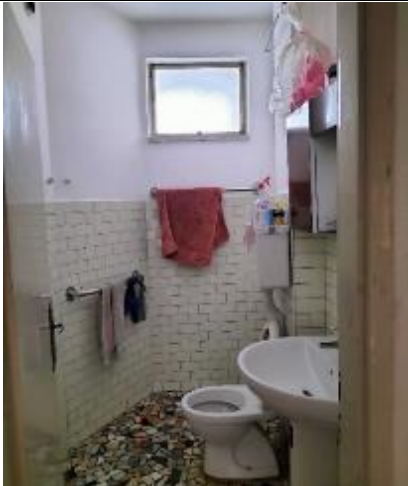
Foto 7: Appartamento P1 Bagno
