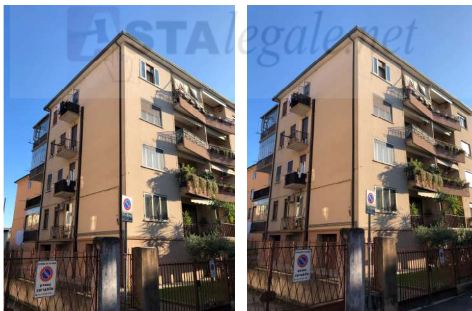
Figura 3. Foto esterne immobile.
