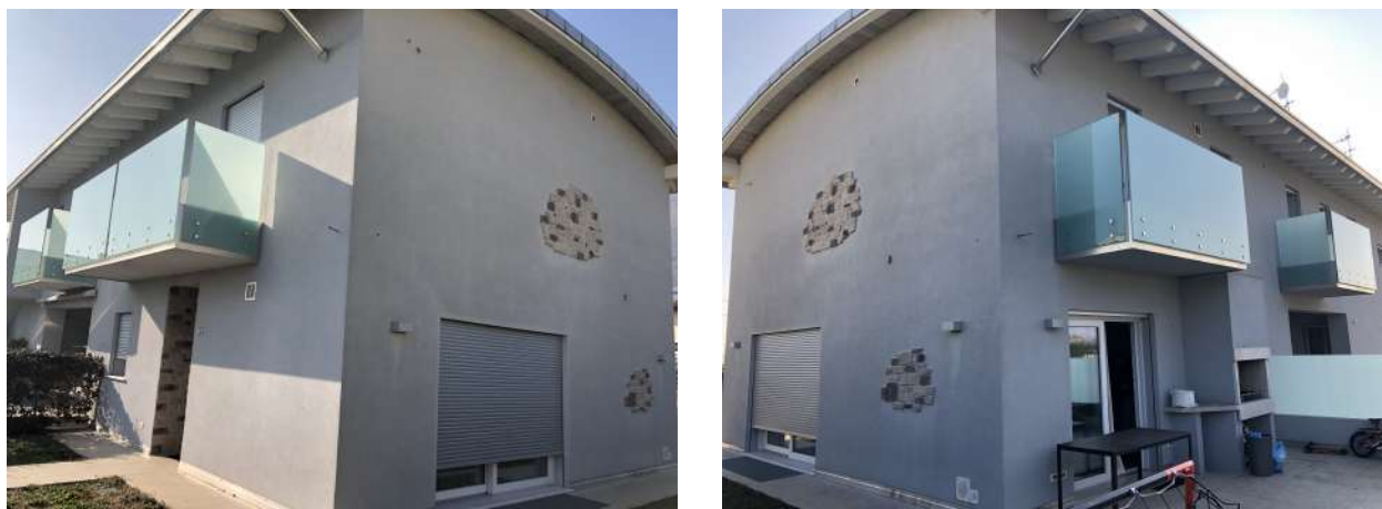
Figura 3. Foto esterne immobile.
