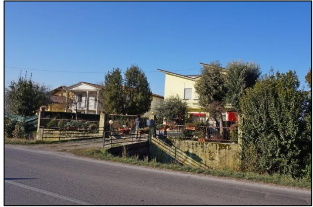
foto 2 - Ponticello di accesso da Via Chiesa Friola
