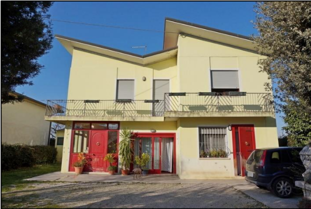
foto 1 - Facciata verso Via Chiesa Friola
