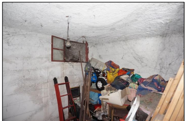
foto 8 - Cantina al P. interrato
