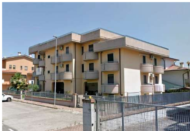
Fabbricato condominiale - vista sud-ovest
