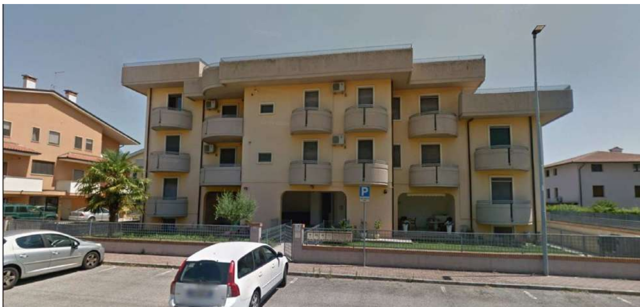
Fabbricato condominiale - vista ovest
