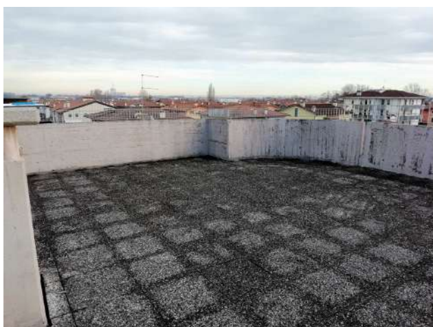
Terrazzo sul tetto
