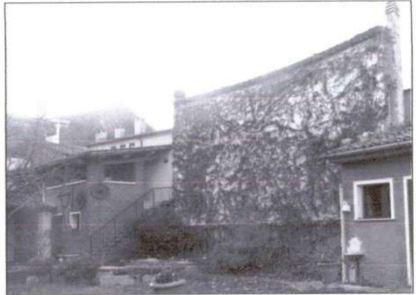
oltre il vecchio muro di proiezione il fabbricato con la C.T.
