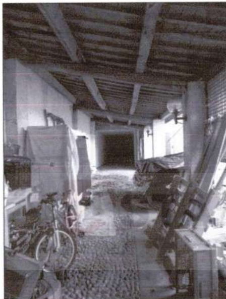
Portico visto dall'uscita di sicurezza
