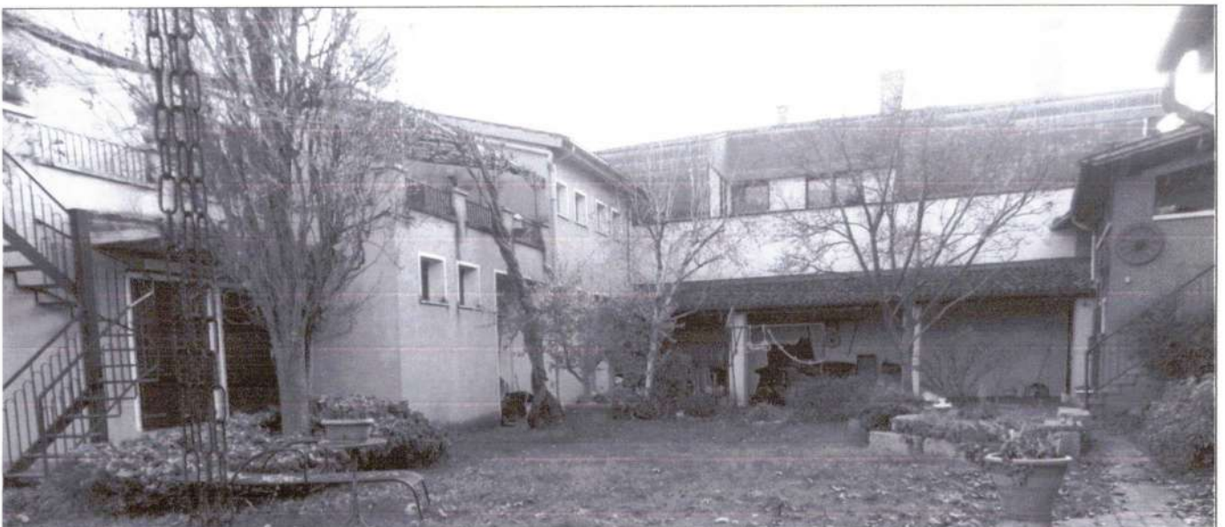
uscite di sicurezza viste dall'abitazione, portico (uscita su via Roma) e fabbricato dov'è localizzata la C.T. (a P.T.)
