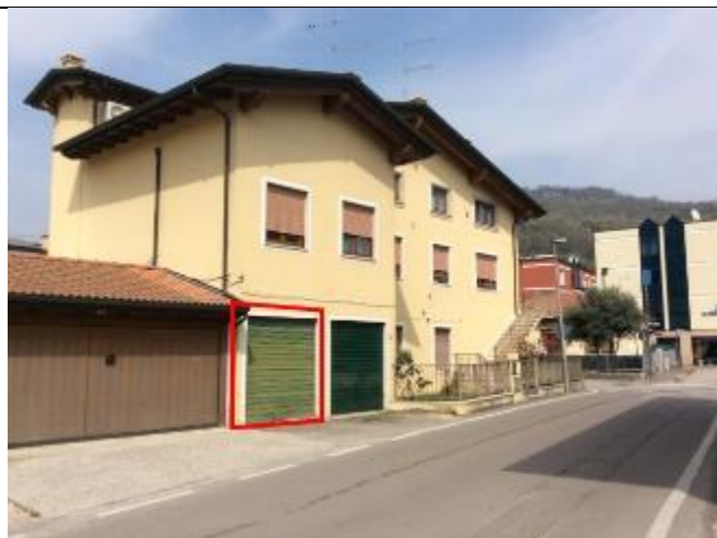
Foto 1: Vista esterna del fabbricato Individuazione garage sub 2
