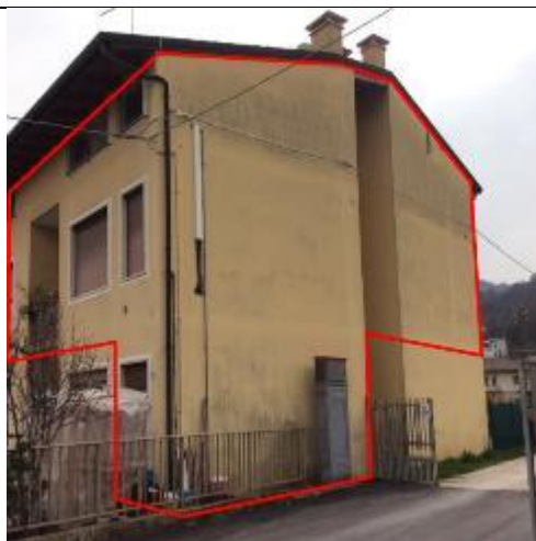
Foto 2: Vista esterna del fabbricato Individuazione appartamento sub 6
