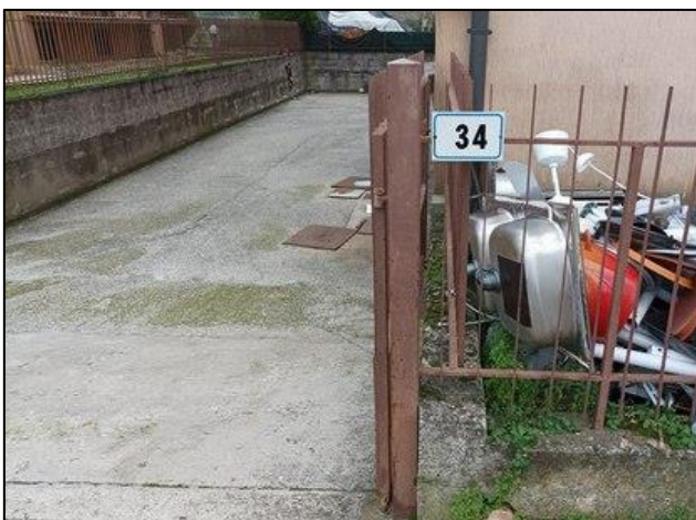
foto 4 - Accesso carraio civico 34
