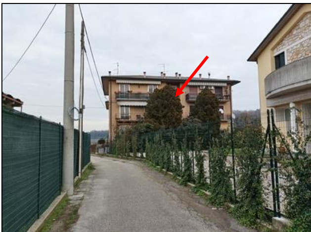
foto 2 - Edificio visto dalla strada di accesso
