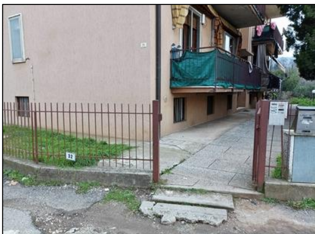
foto 3 - Cancelli di ingresso pedonale civico 32
