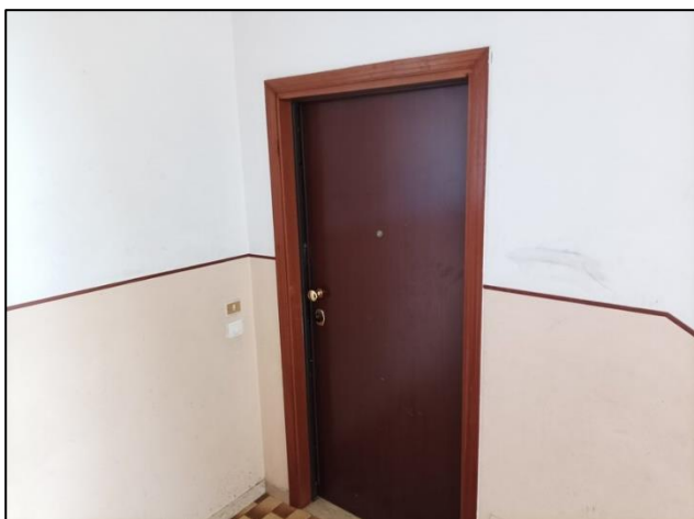
foto 7 – Portoncino di ingresso
