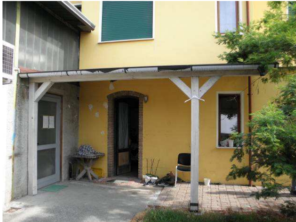
VISTA ESTERNA RETRO
