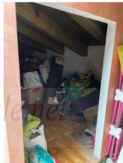
Foto 29. Soffitta (non autorizzato)
