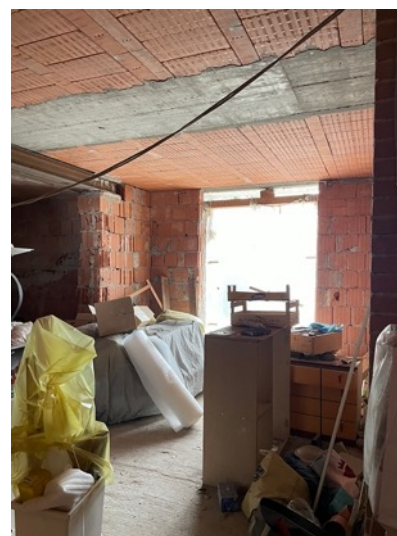
Foto 37. Piano terra in corso in costruzione
