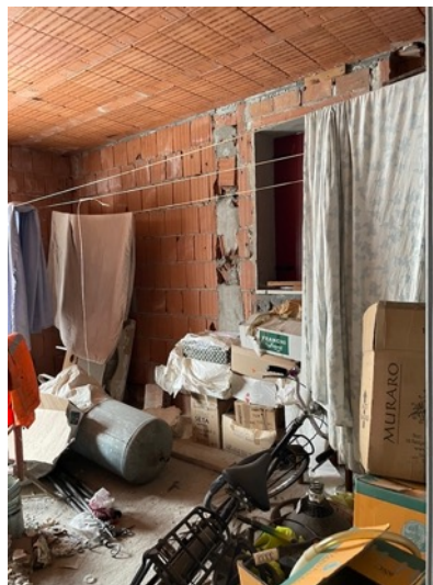
Foto 39. Piano terra in corso in costruzione
