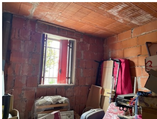
Foto 43. Piano terra in corso in costruzione
