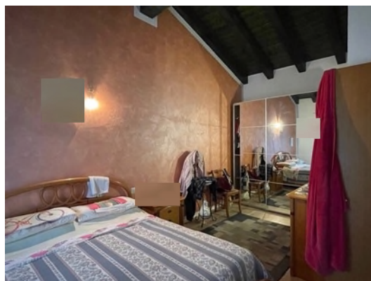
Foto 33. Stanza 3 (lo stato autorizzato prevede la realizzazione di un solaio piano, non travi a vista)
