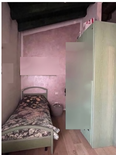
Foto 32. Stanza 2 (lo stato autorizzato prevede la realizzazione di un solaio piano, non travi a vista)
