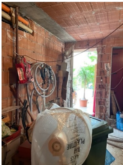
Foto 45. Piano terra in corso in costruzione
