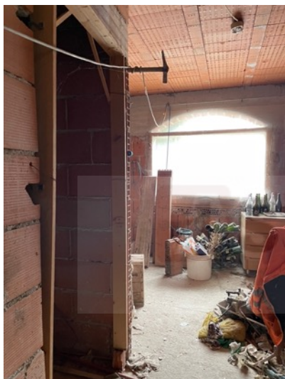
Foto 40. Piano terra in corso in costruzione
