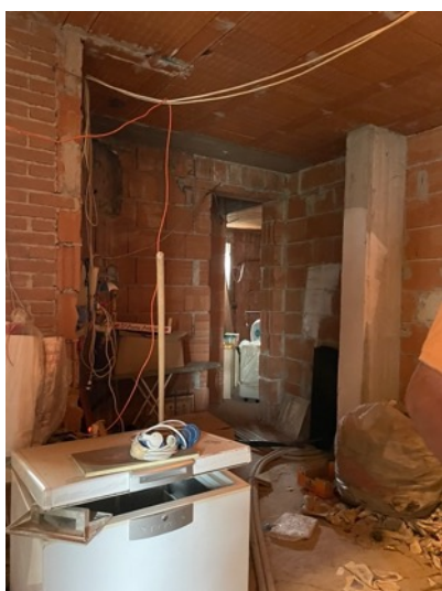
Foto 36. Piano terra in corso in costruzione
