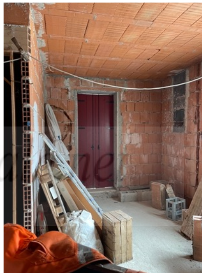
Foto 41. Piano terra in corso in costruzione
