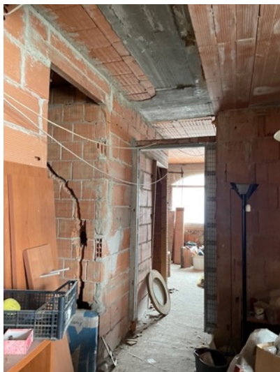
Foto 38. Piano terra in corso in costruzione
