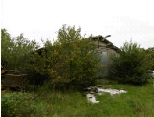
Prospetto principale lato nord
