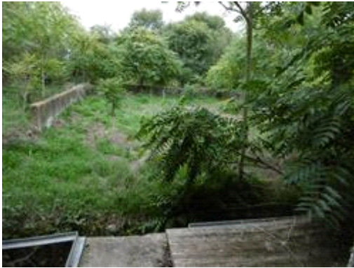
Area esterna retro fabbricato
