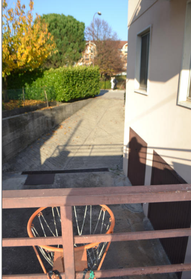
Rampa di accesso in lisciata di cemento
