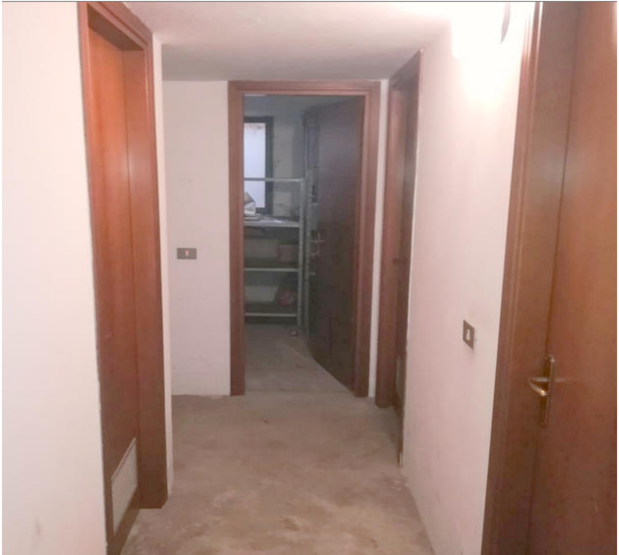
Figura 2- VISUALE DELLA CANTINA POSTA AL PIANO SEMINTERRATO
