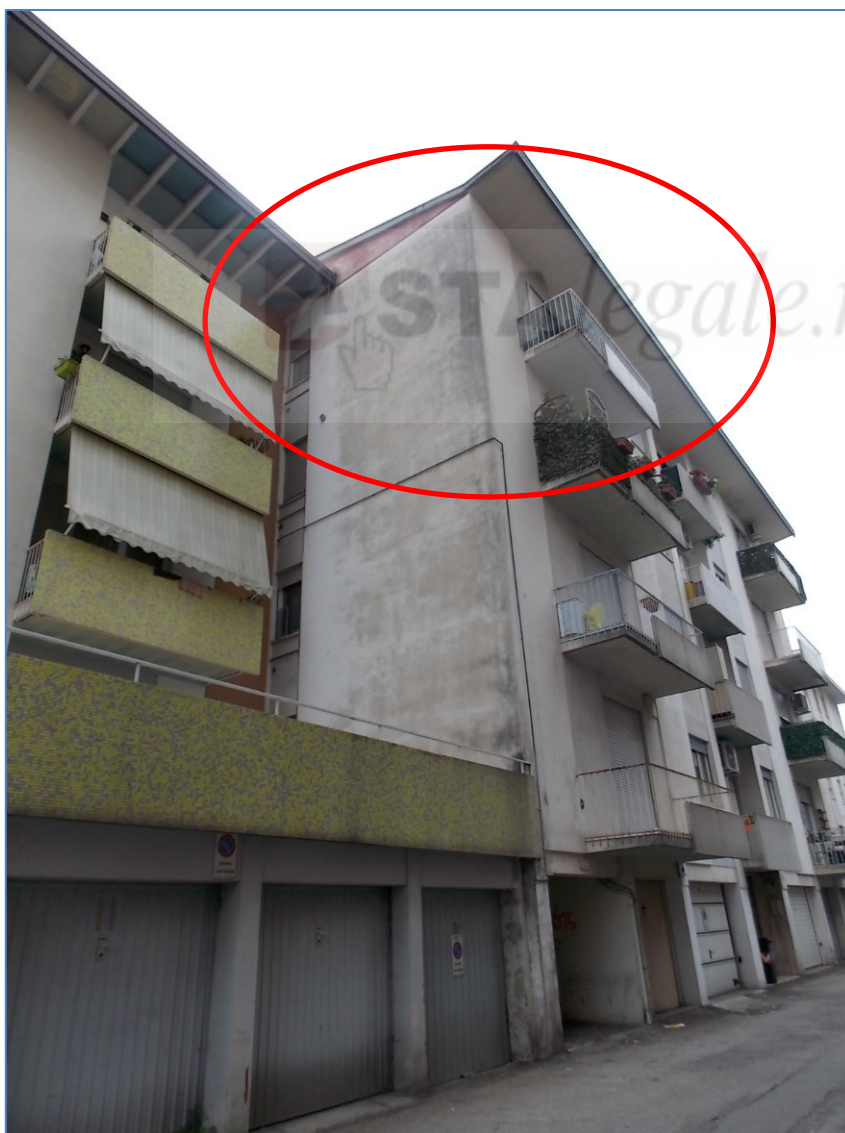
via dei Castellani, n° 11 Schio, abitazione piano 4°
