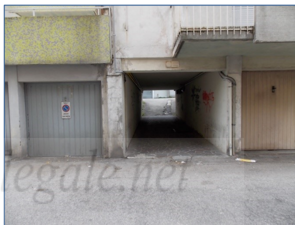
Accesso sottoportico comune
