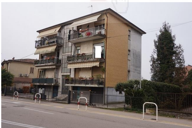
Fabbricato da nord/est
