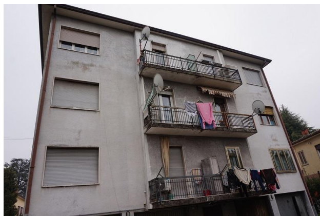
Fronte ovest fabbricato condominiale
