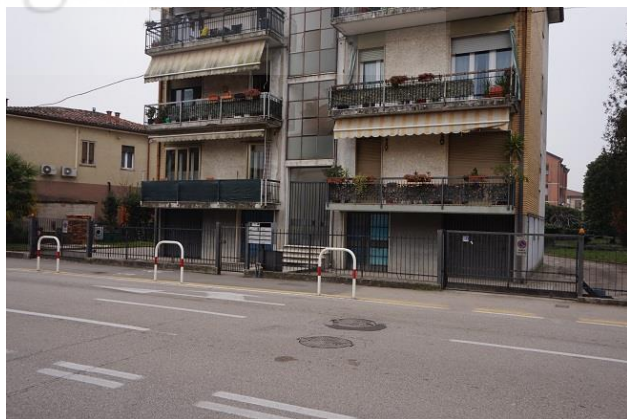
Accessi carraio e pedonale fronte est
