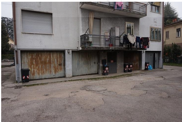
Ingressi garage da corsia di manovra a ovest
