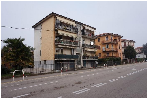
Fabbricato da sud/est
