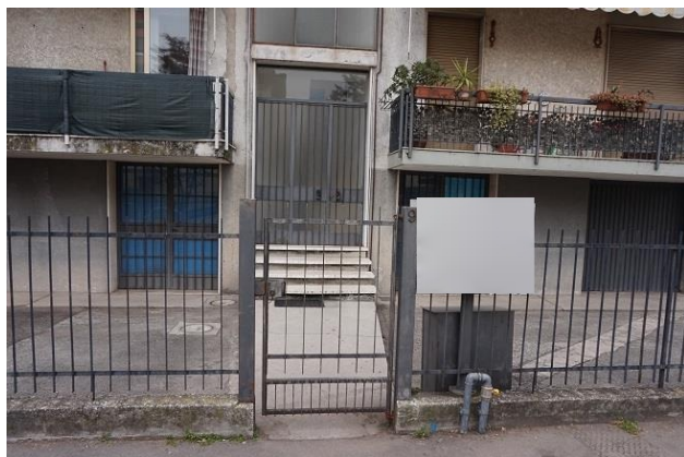
Accesso pedonale fronte est
