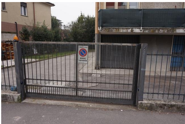
Accesso carraio a est (a sud dell'accesso pedonale)
