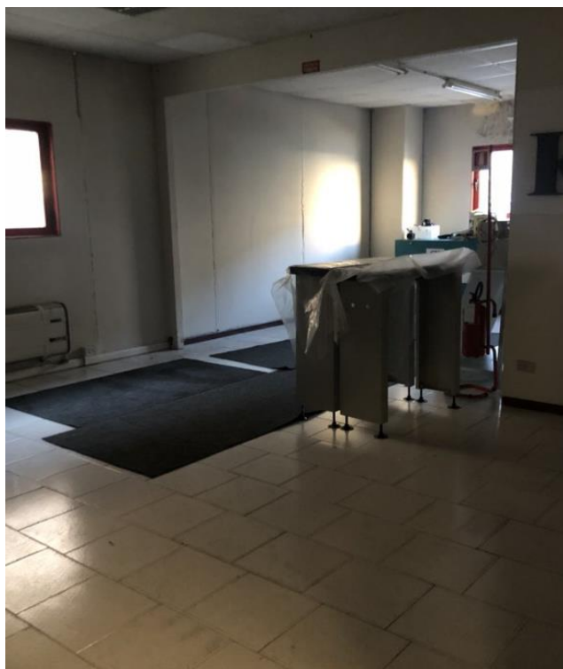
FOTO 9 – Interno Locale ex Mensa
