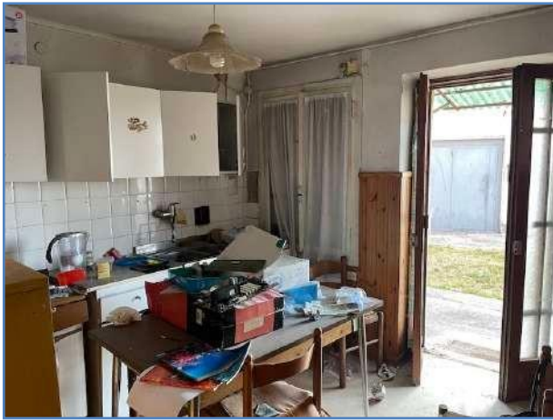
03. Piano Terra - Ingresso e cucina
