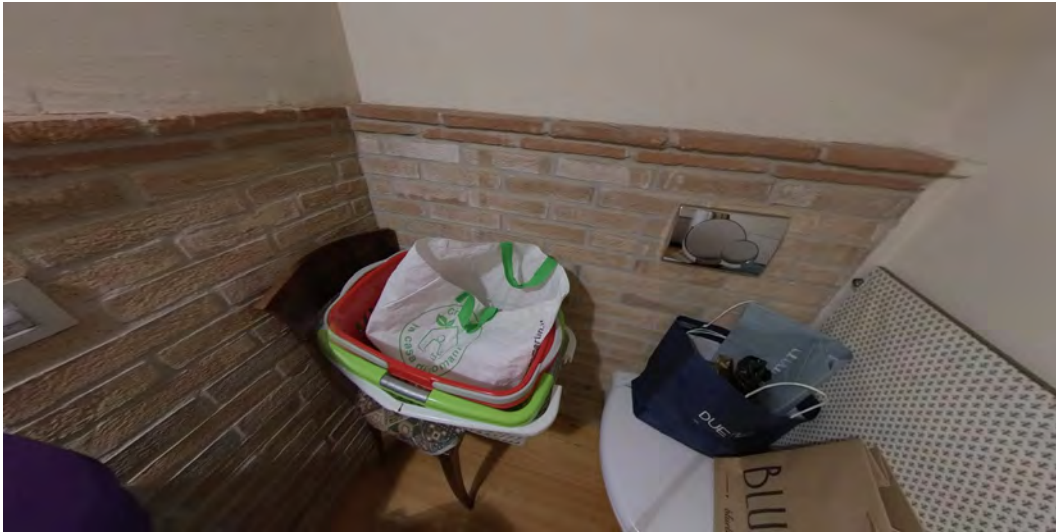
WC stiereria a piano ammezzato
