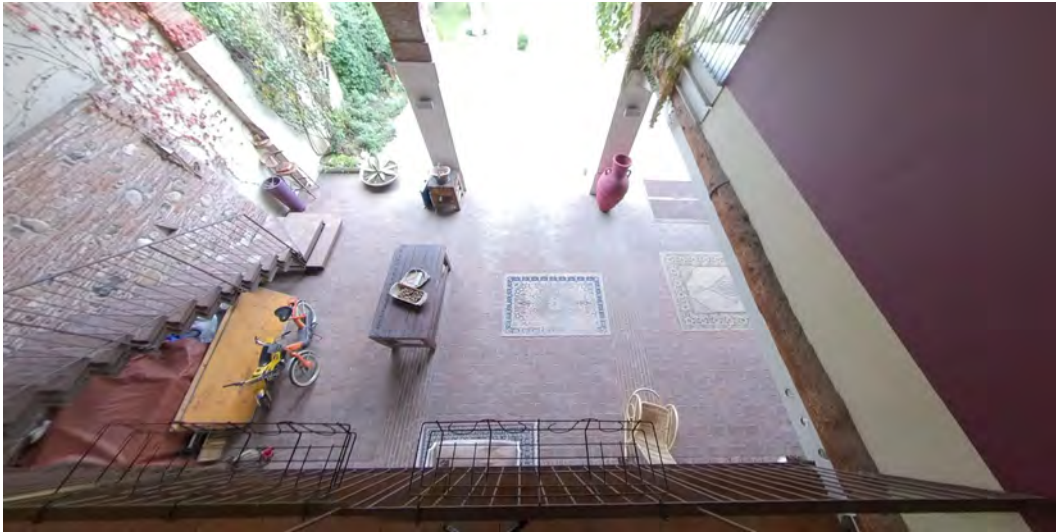
Veduta portico da altro ballatoio
