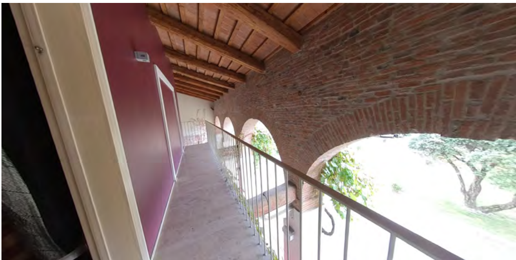
Ballatoio-terrazzo su portico
