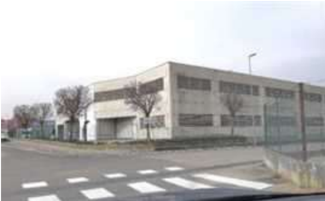
Vista del fabbricato uso rimessa per camper
