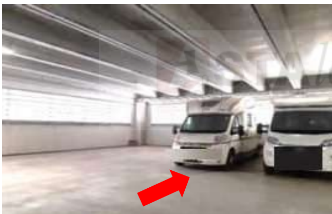
Vista interna dellacorsia della rimessa
