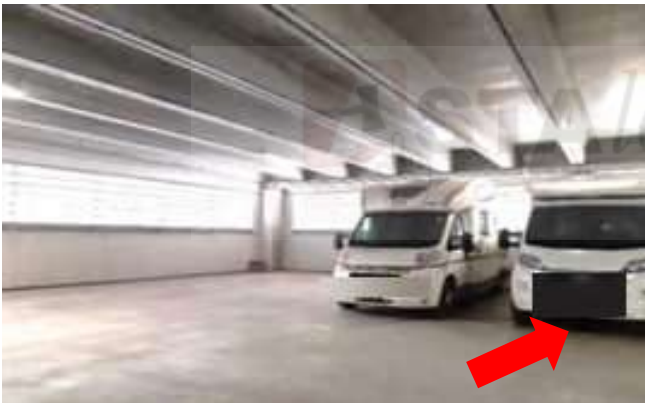
Vista interna dellacorsia della rimessa
