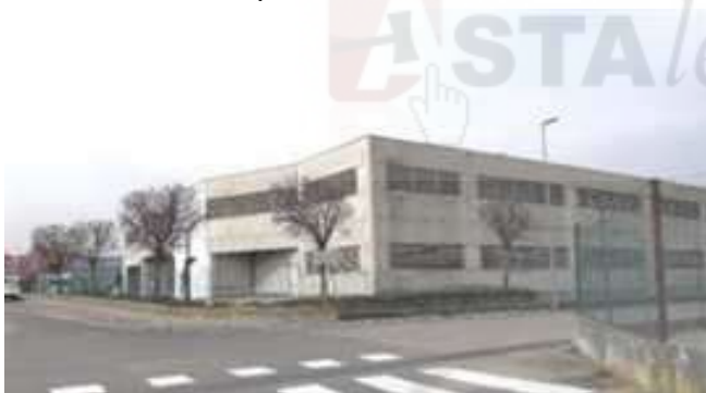
Vista del fabbricato uso rimessa per camper
