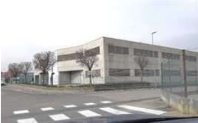
Vista del fabbricato uso rimessa per camper
