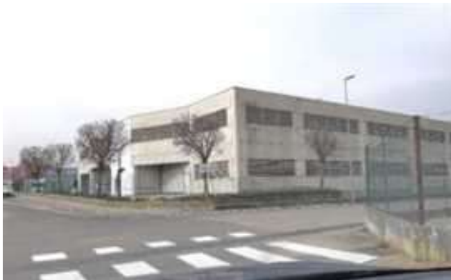
Vista del fabbricato uso rimessa per camper
