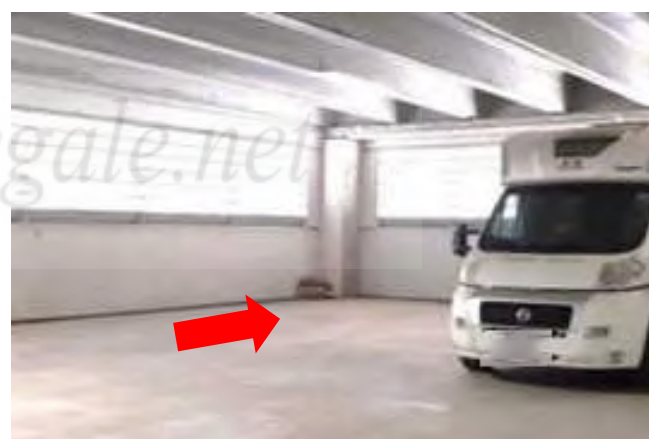
Vista interna della rimessa sub 138
