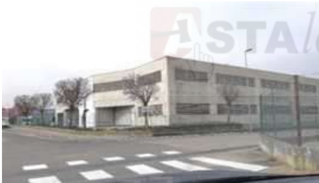
Vista del fabbricato uso rimessa per camper
