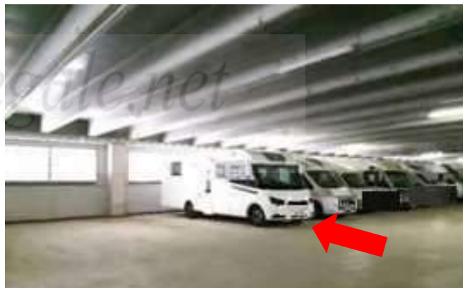
Vista interna della rimessa sub 143
