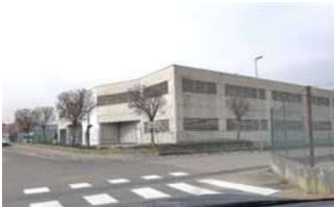
Vista del fabbricato uso rimessa per camper
