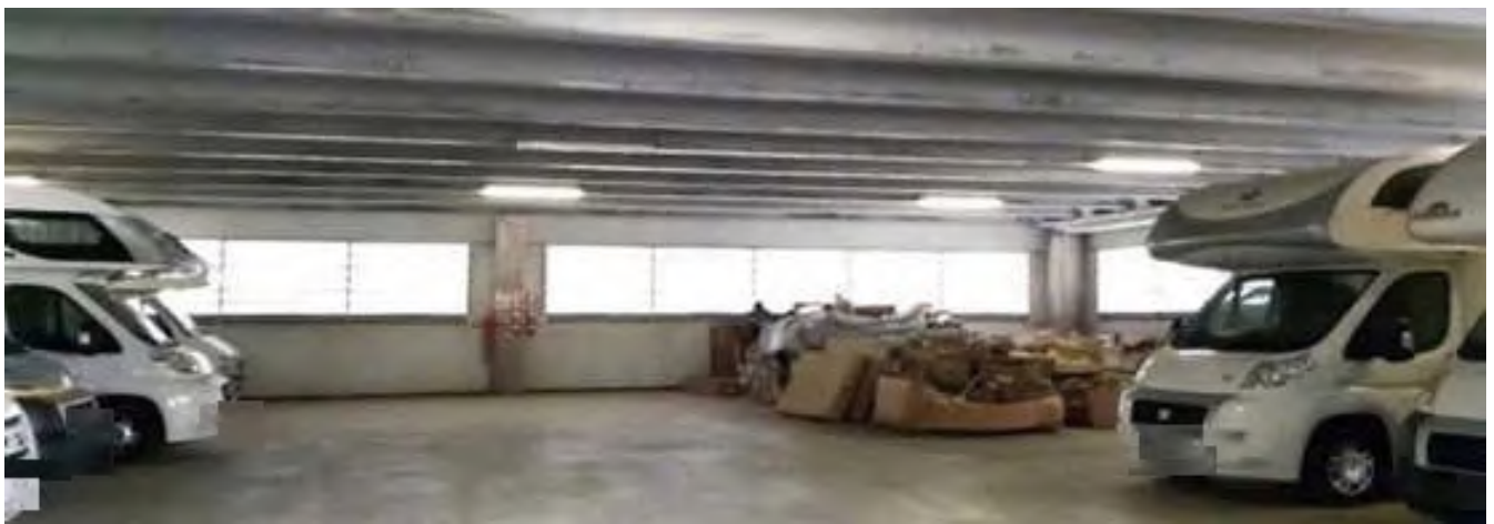
Vista della corsia di manovra con il settore dei 6 posti camper di cui al lotto n.19
