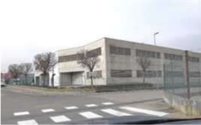
Vista del fabbricato uso rimessa per camper
