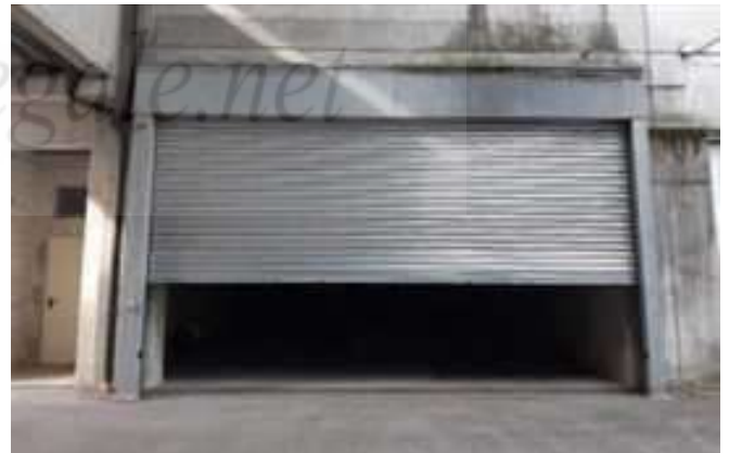
Vista del portone di ingresso al piano interrato
