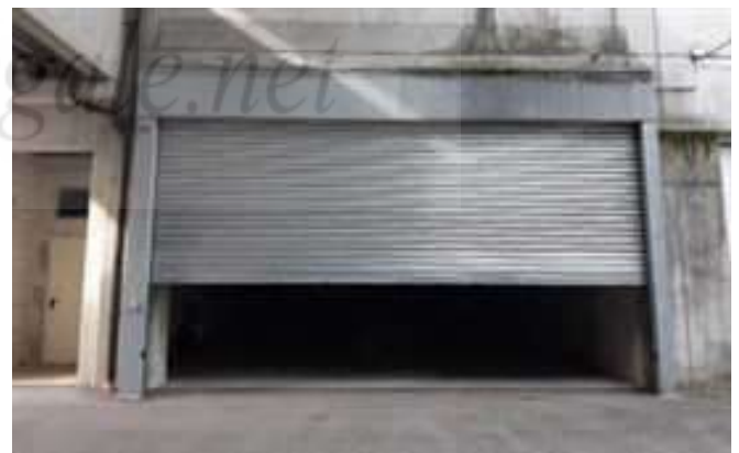
Vista del portone di ingresso al piano interrato
