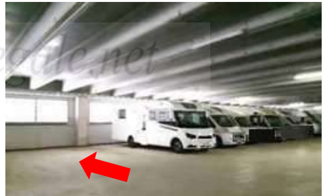
Vista interna della rimessa sub 141
