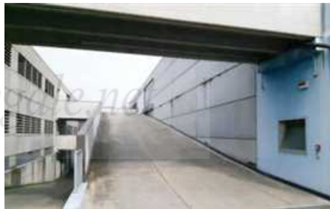
Vista della rampa di collegamento con il piano primo
