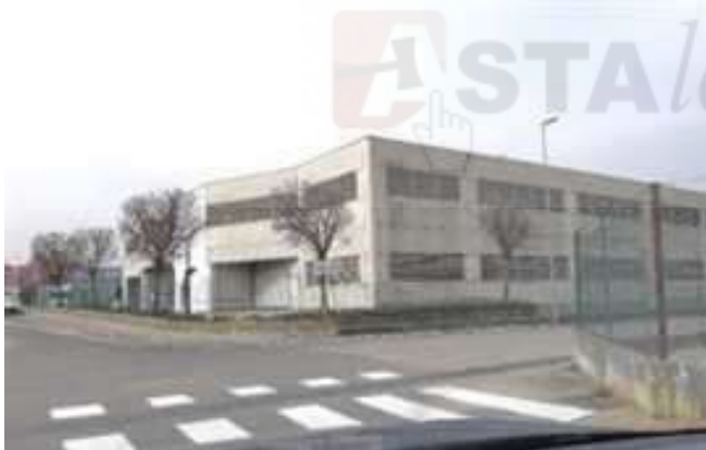
Vista del fabbricato uso rimessa per camper
