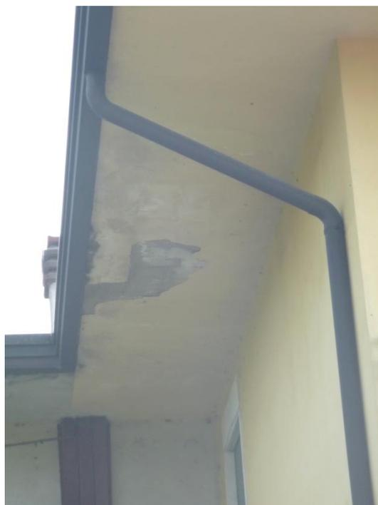
Abitazione mapp. 521 sub. 2-3 – presenza di infiltrazioni nel cornicione del fabbricato
