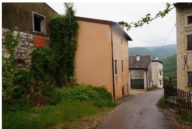
Fronte sud fabbricato da via Casalin
