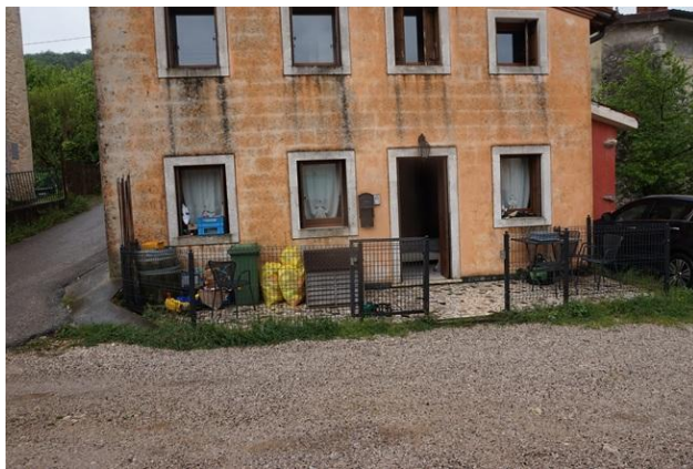
Vista Particolare ingresso su fronte nord fabbricato
