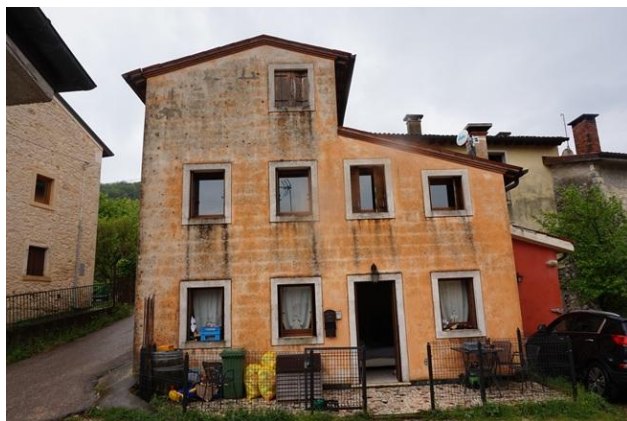
Fronte nord fabbricato da corte comune
