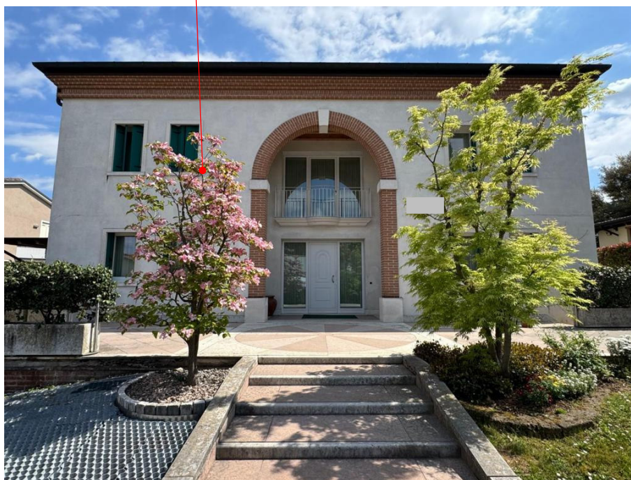
1. – vista panoramica lato Nord-Ovest
