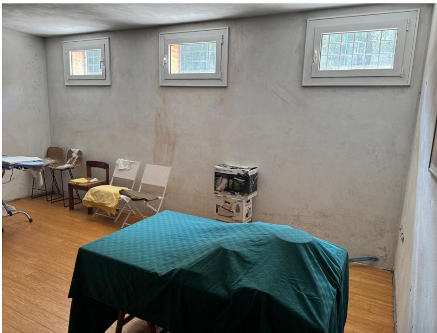
11. – Abitazione: zona interrato
