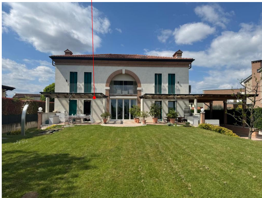
2. – vista panoramica Sud-Est
