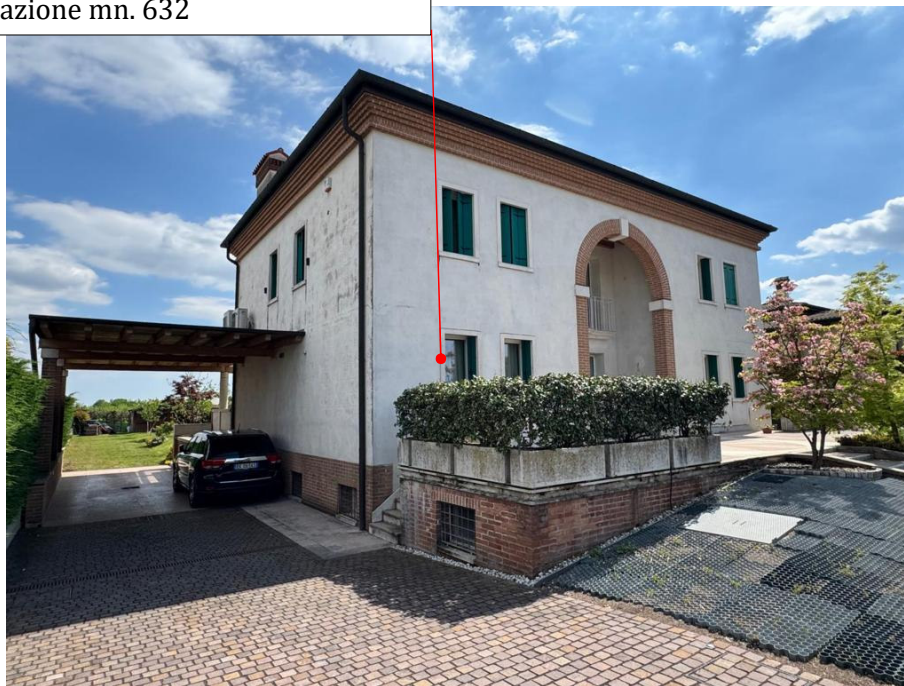
3. - vista panoramica Nord
