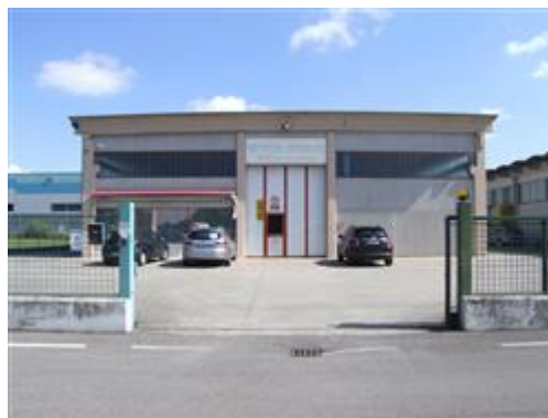
Veduta dell'immobile da Sud
