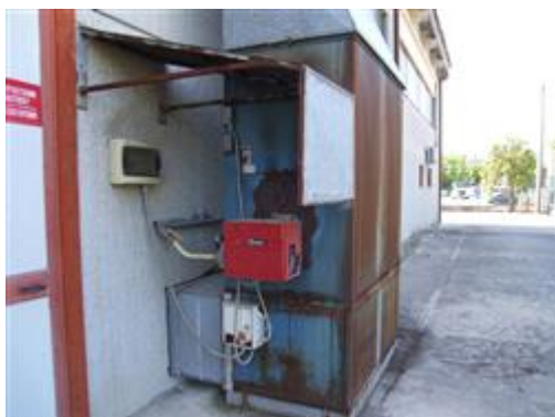
Posizionamento impianto di climatizzazione invernale
